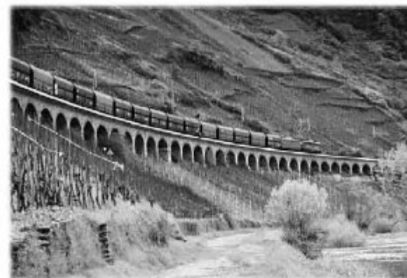
98 Steinbögen bilden das längste zweigleisige Bahnviadukt Deutschlands
